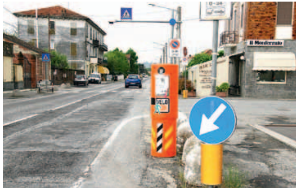
Un “Velo Ok” installato all’ingresso dell’abitato di Roncaglia
